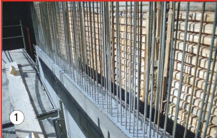
Die Fotos zeigen eine ältere Ausführung, bei der das Fugenband von einer Baustahlmatte gehalten wurde (1, 2, 3).
