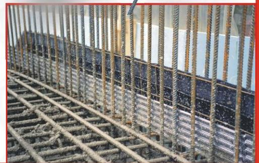
**Ausschreibungstext** Schalungselement für Aufkantung aus wellprofilierem Lochblech und Fugenbandhalter. Aufkantungsbreite = B: ..... mm, Aufkantungshöhe = H: ..... mm Fabrikat: **MSL - Typ AKB** ..... Menge ..... lfdm. Preis (m) € ..... Gesamt ..... €
