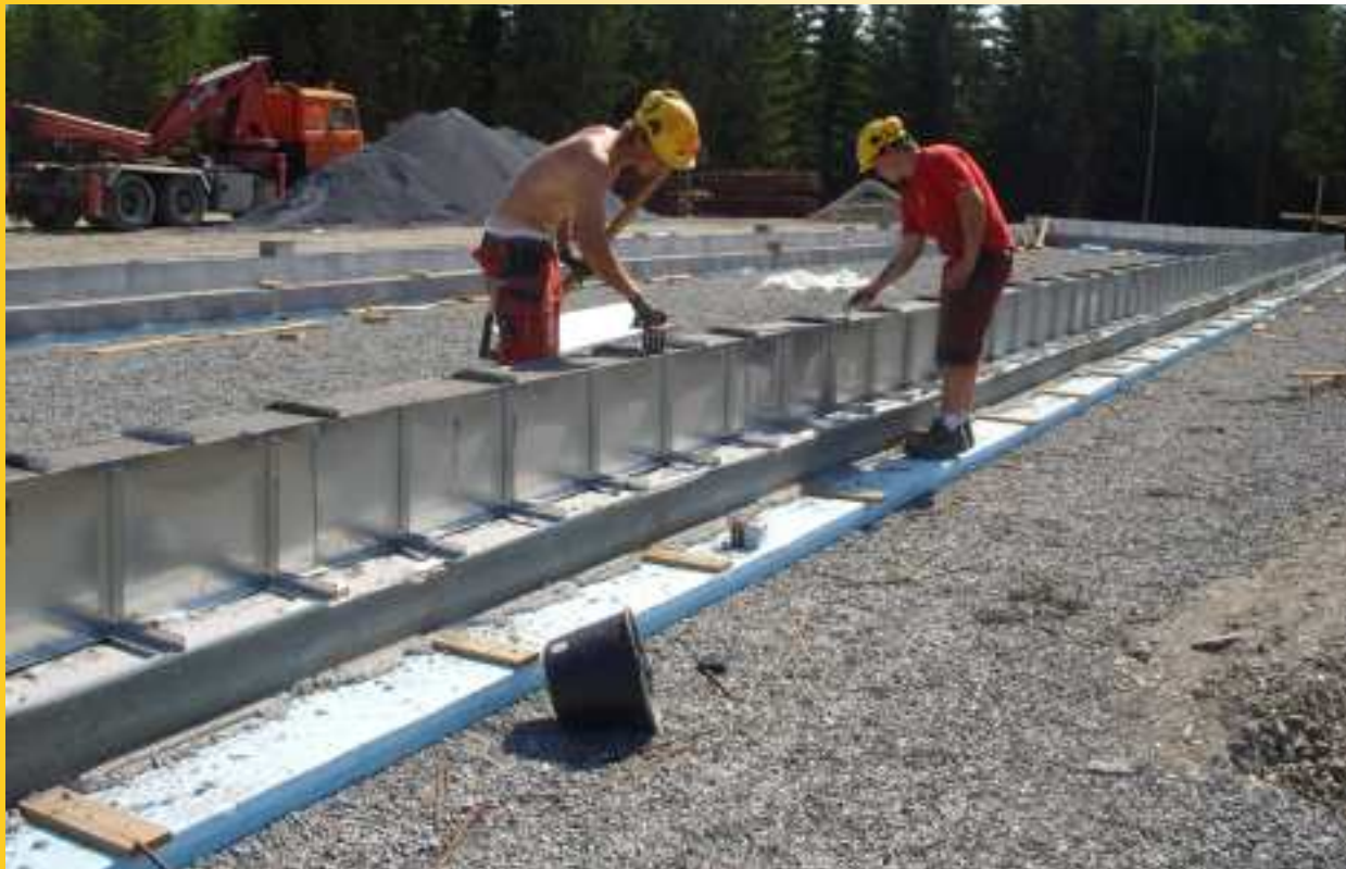
Randschalung RA Wall shuttering RA
