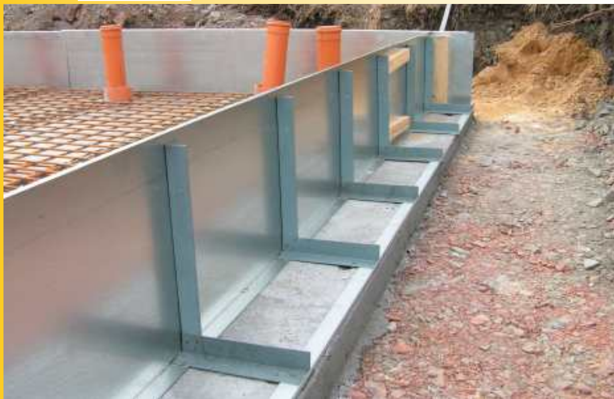
Randschalung RA Wall shuttering RA
