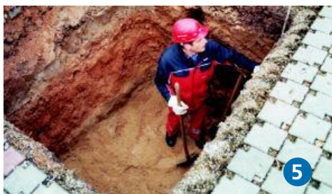
Anwendungsbeispiel: Strommastfundament, Foto 5 bis 10
