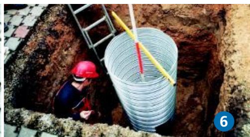
Anwendungsbeispiel: Strommastfundament, Foto 5 bis 10
